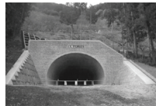
高幡山トンネル
